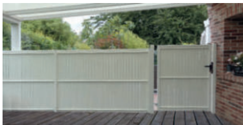
Pose en claustra de séparation
