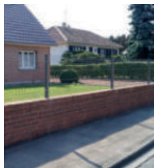
Pose sur muret
