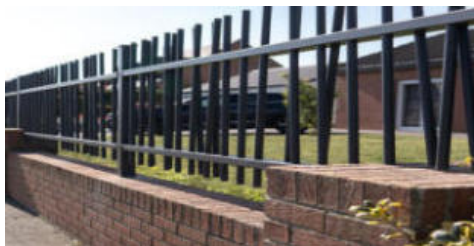
Pose sur muret
